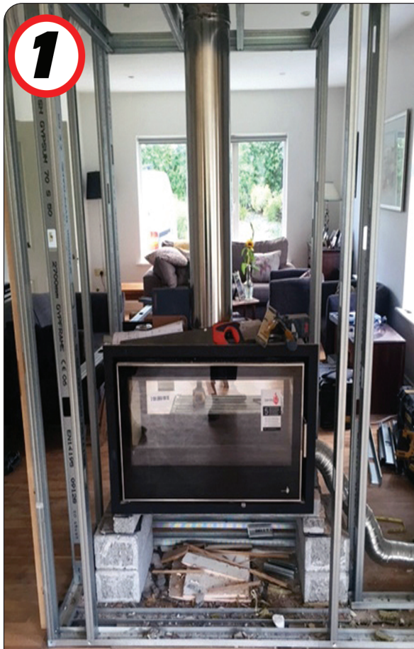
- INSTALLING INSERT STOVE USING METAL STUD FRAME
